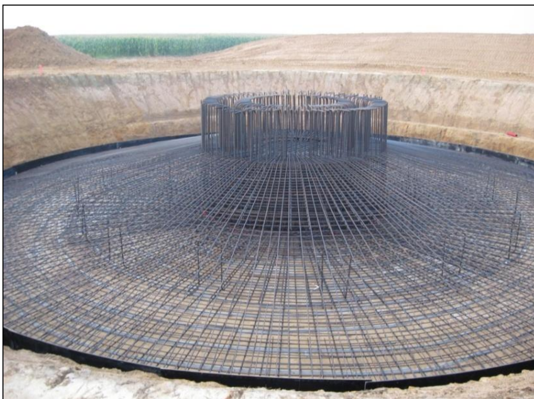
Figure 51 : Ferrailage d'une fondation d'éolienne
