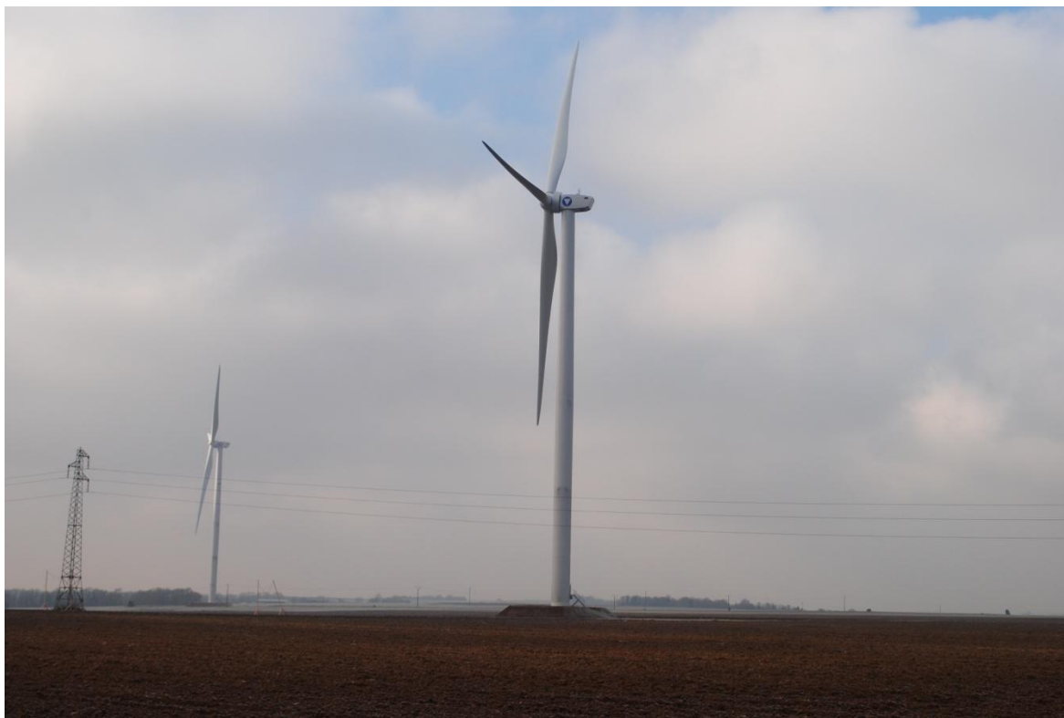
Figure 11 : La Vensys 120, parc éolien de Leury.
