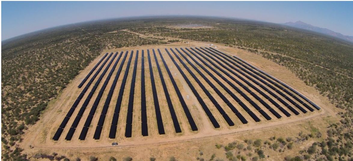
Figure 9 : Parc photovoltaïque d'Omburu (5 MW), Namibie, 2015. Développé par InnoSun, filiale d'InnoVent.
