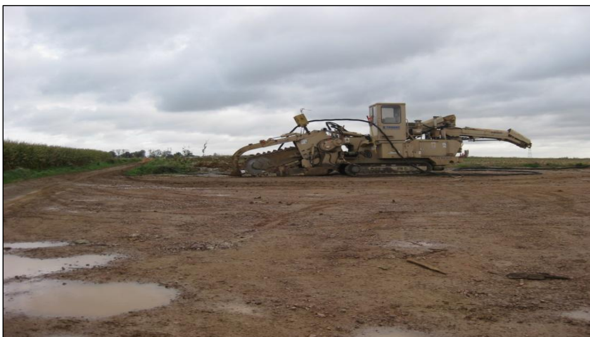
Figure 52 : Enterrement d'un câblage d'éolienne en plein champ
