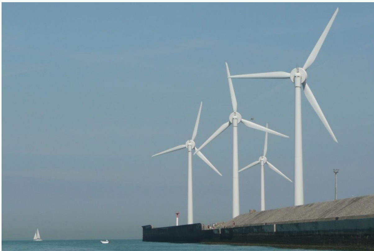
Figure 7 : Parc éolien de Le Portel (62), en production depuis 2002.
