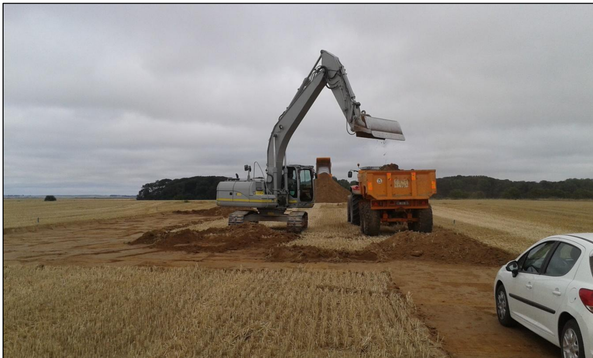
Figure 50 : Création d'une plate-forme
