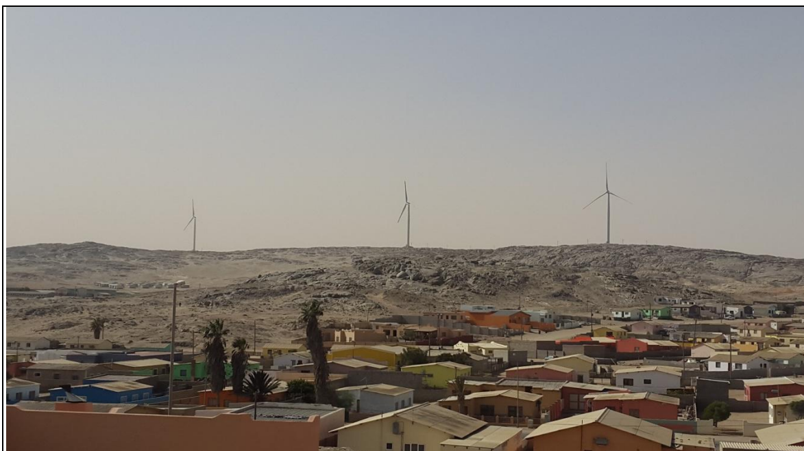
Figure 8 : Parc de Lüderitz, Namibie. Développé par InnoSun, filiale d'InnoVent.
