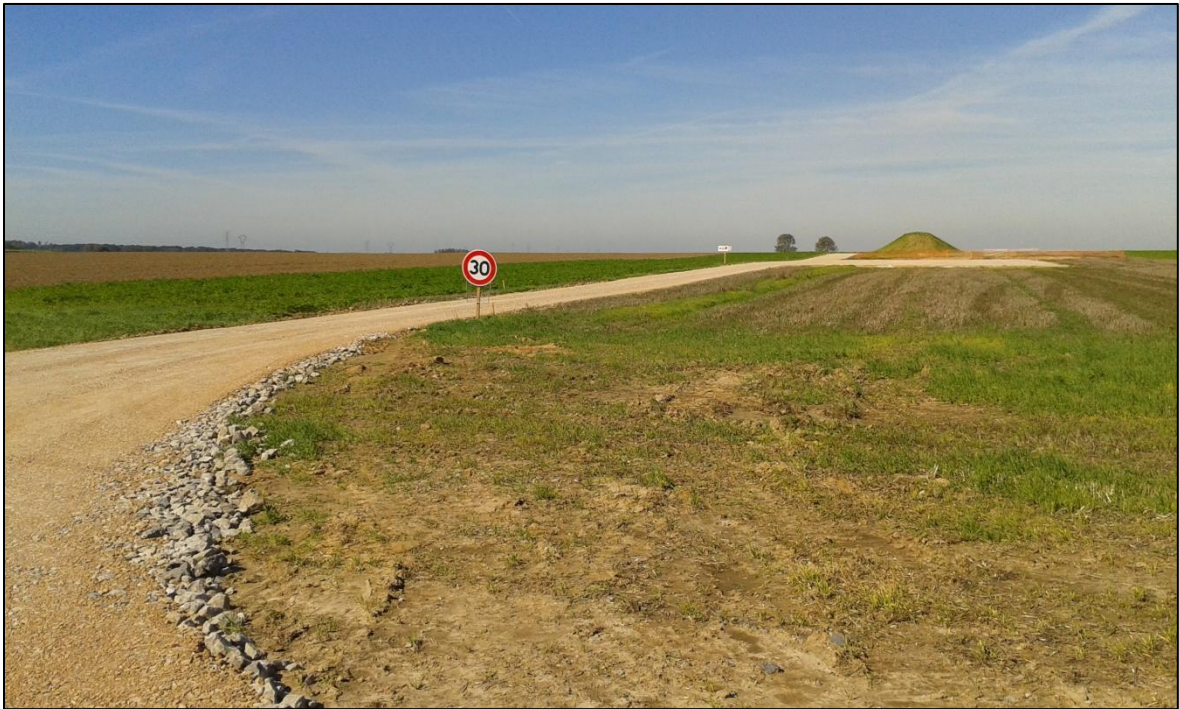
Figure 48 : Un chemin d'accès type (plate-forme en arrière plan)
